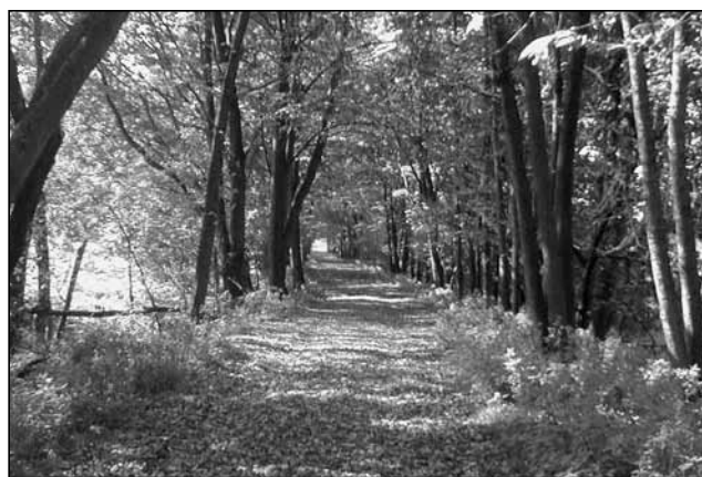
Drážní těleso - pohled od severu k jihu
